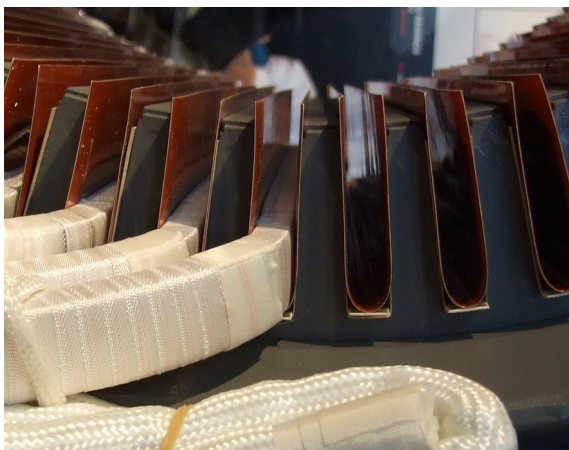
Obr. 8.2: Vinutí v průběhu vkládání do drážek
