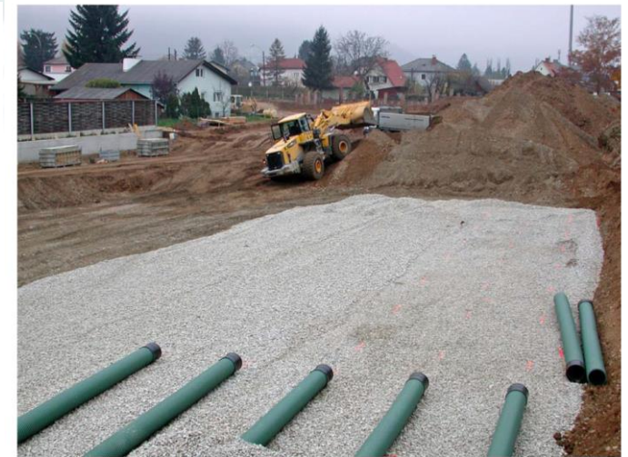
Foto: Die aufwendige Verlegung des unterirdischen Drainagerohrsystems
