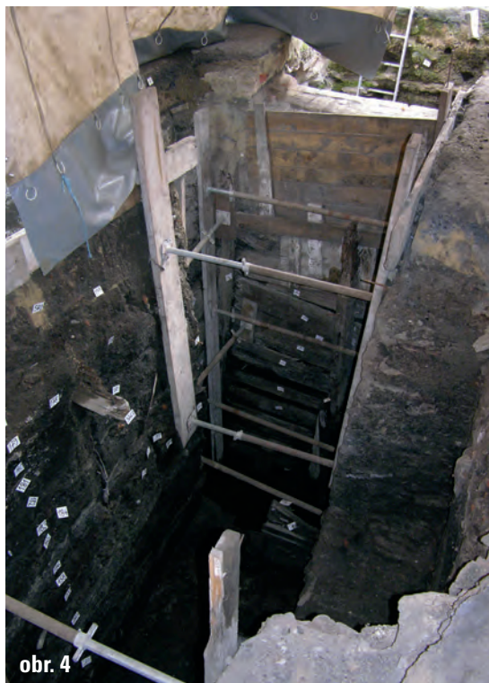
Zajištěné výkopy záchranného archeologického výzkumu v trase inženýrských sítí (Opava 2006, výzkum NPÚ). Foto autor.
