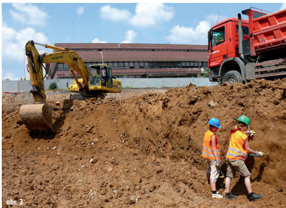
obr. 3 Pracovníci archeologického výzkumu vybavené základními osobními ochrannými pomůckami na archeologickém výzkumu, který je zároveň stavenišťem (Praha – Dejvice, 2009). Foto L. Drápela.
